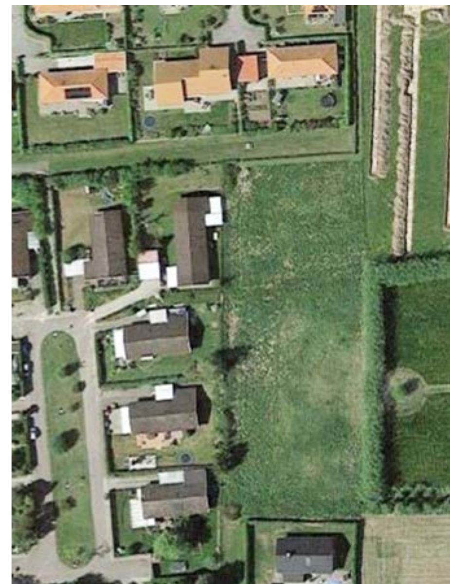
Luftfoto af grunden i Sørog. Der skal være fælles indkørsel fra Jernbæk Alle
