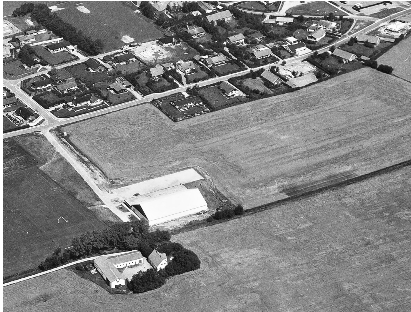
Luftfoto af Ramløsehallen - taget kjort efter færdiggørelsen
