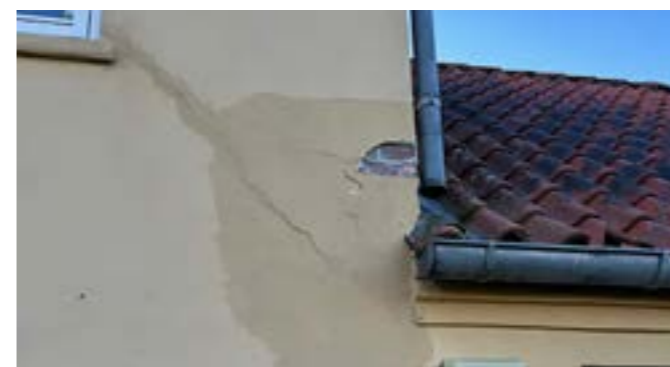
Der er desværre kommet en del fugtskader på møllen og møllehuset. Vi håber på en snarlig udbedelse af skaderne
