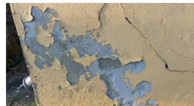
Der er desværre kommet en del fugtskader på møllen og møllehuset. Vi håber på en snarlig udbedelse af skaderne
